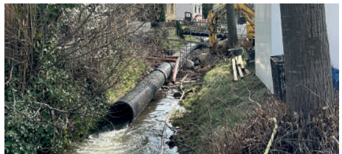
Um die zerstörten Brücken an der Alten Bachstraße in Schwerfen erneuern zu können, musste zunächst der Rotbach im betreffenden Bereich trockengelegt und durch eine Rohrleitung geführt werden. Foto: Stadt Zülpich / Torsten Beulen
